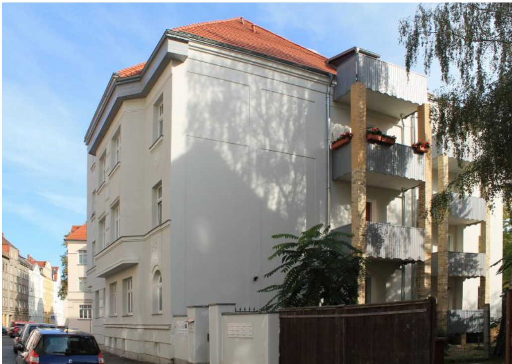
Blick auf die südliche Hausfront (Hofseite)
