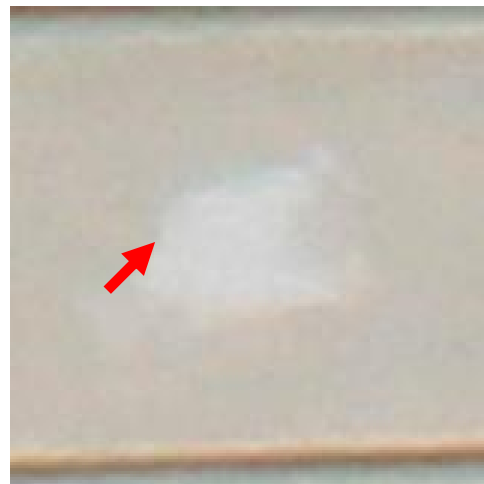
Farbgebung einer Ausbesserungsstelle an der Außenfassade
